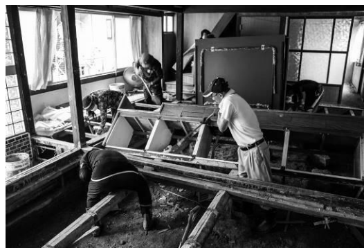
家屋内、敷地内の土砂の撤去
