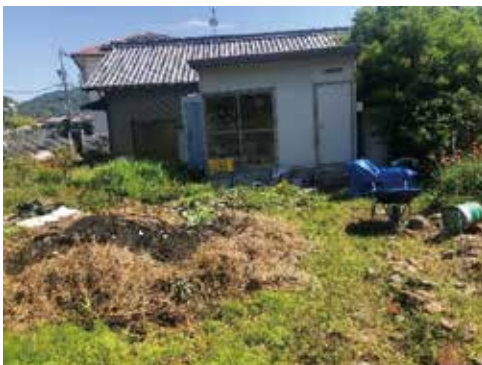
プレハブ小屋の外観
