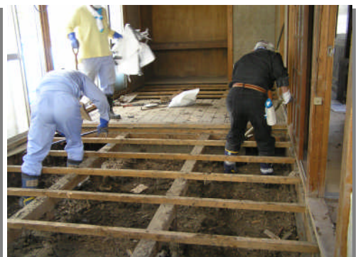
床下の土砂をかき出し
