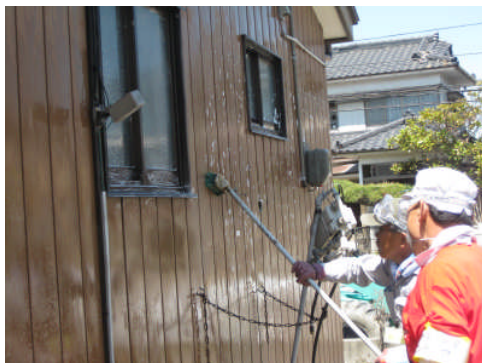
津波で汚れた外壁の掃除
