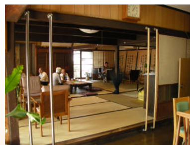
段差解消に手すりを取り付けています
